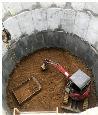
图1 非开挖顶管施工工作井
