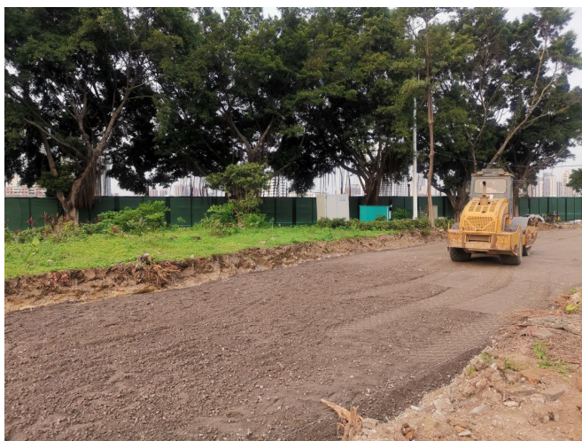
图 1 大型静压压路机
