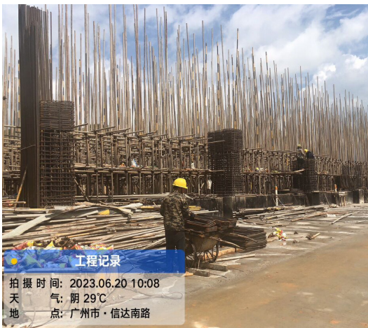
图 1 支架搭设现场图
