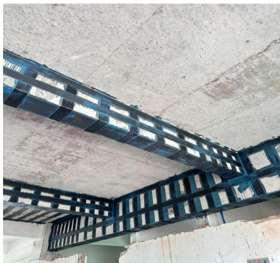
图 3 FRP 加固技术应用图
