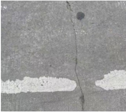
图 1: 接缝料损坏
