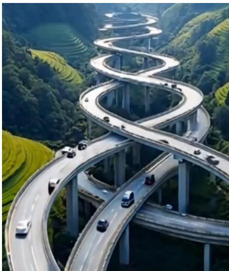
图1 恶劣地形条件下的公路
