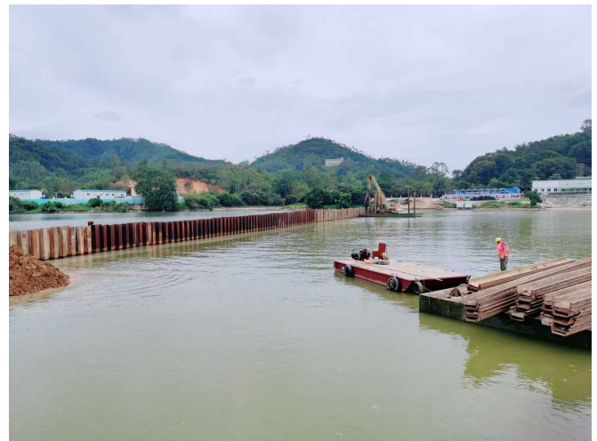
图 1：导向架施工现场
