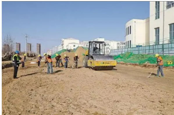
图1 道路衔接段换填碾压
