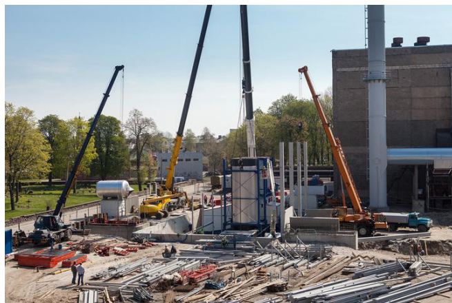
图1：建筑工程施工管理的进度管理现场
