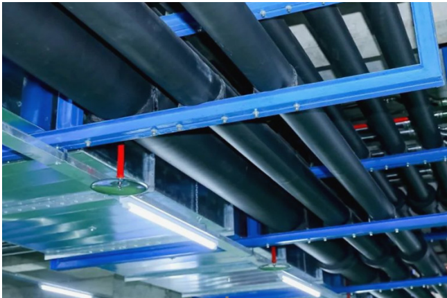
图 1 整体顶升完成实景图
