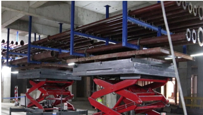
图 5 整体顶升施工
