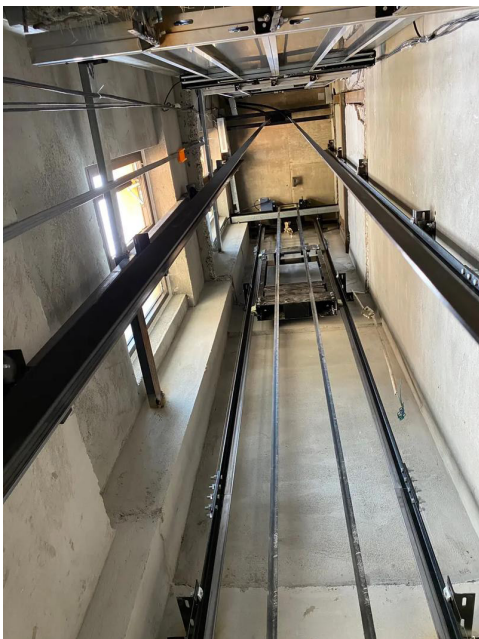
图1 电梯导轨支架的安装
