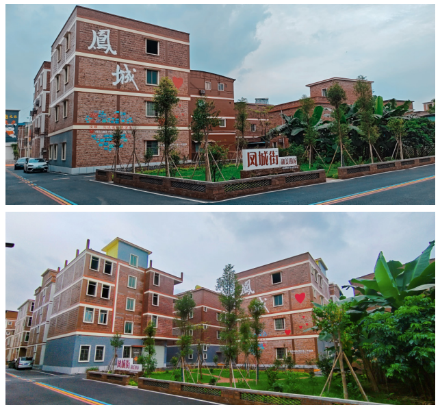
图1 清城区凤城街办某社区农房风貌提升实景图
