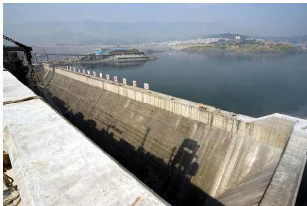
图1 水利工程混凝土围堰
