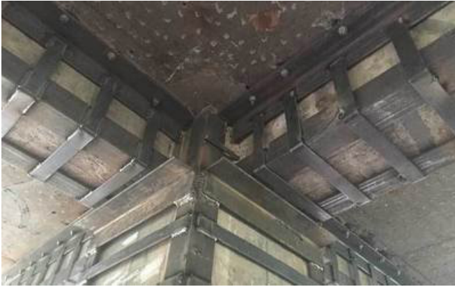
图 2 外包钢加固法
