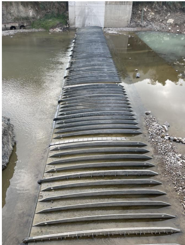
图4 3#气质坝完工照片
