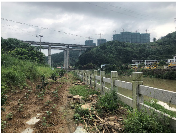
图3 桩号 W3+000 左岸已建护岸
