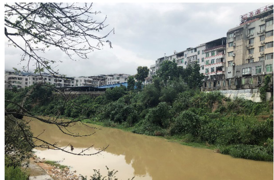
图1 右岸桩号W0+300治理前（汛期）
