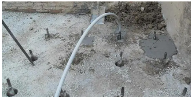
图 1 地基注浆加固
