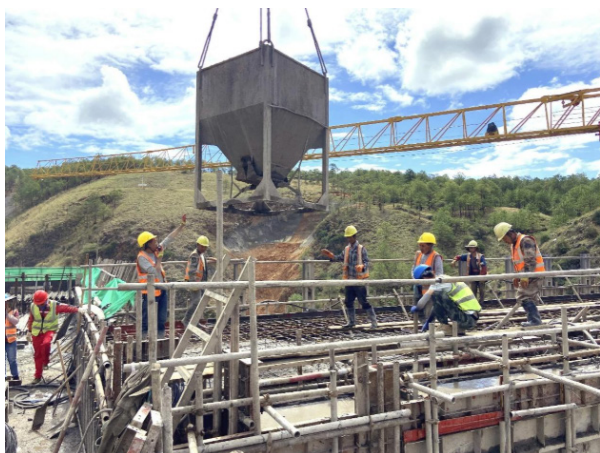
图 1 混凝土坝浇筑现场
