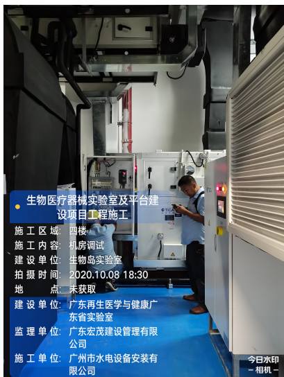
图 1: 生物医疗器械实验室及平台建设项目工程施工
