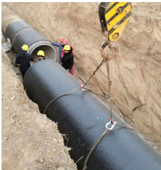
图2 管道吊装
