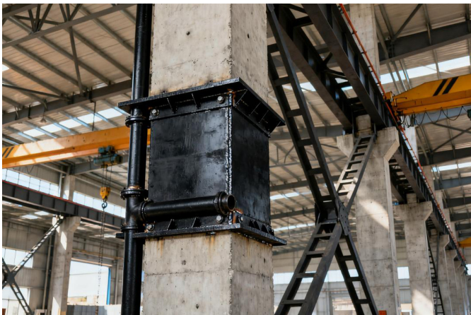
图2. 外包钢加固法
