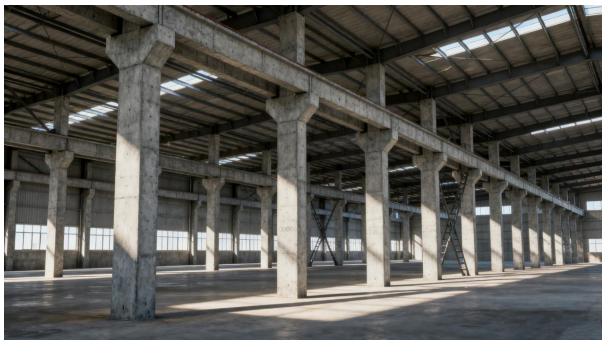
图1. 工业厂房混凝土排架柱
