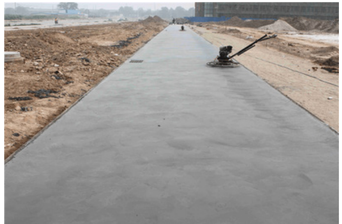
图 1 混凝土路面施工
