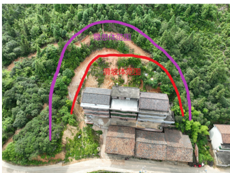
图1 滑坡隐患山体全貌
