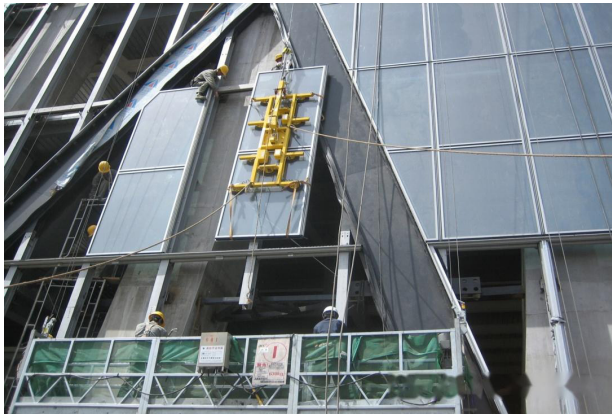
图 1 异型幕墙单元吊装施工现场图
