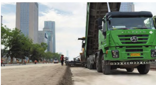
图 1 摊铺作业现场
