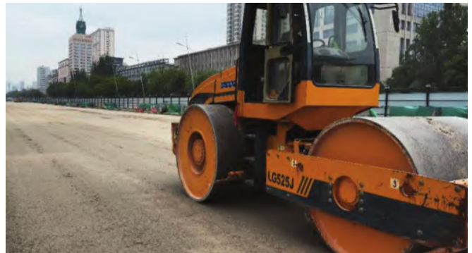
图 2 碾压施工现场
