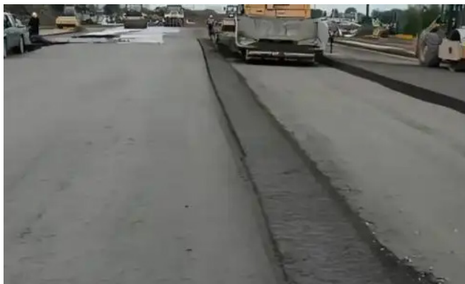
图一 沥青道路施工分层摊铺工艺
