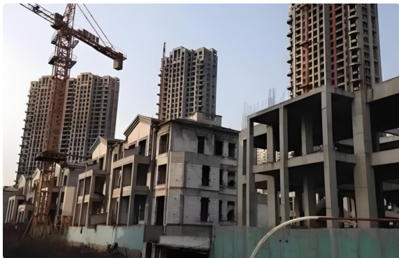
图 2：某小区建设施工现场
