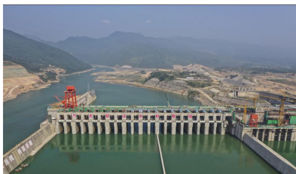
图1. 某省水坝施工过程图
