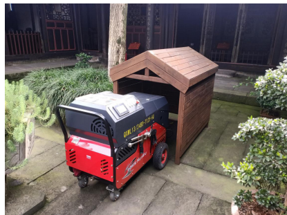
移动高压细水雾灭火装置防雨木屋
