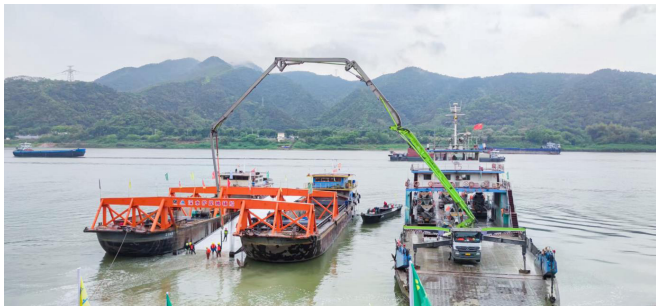
图四：超深动水环境下模袋混凝土摊铺施工
