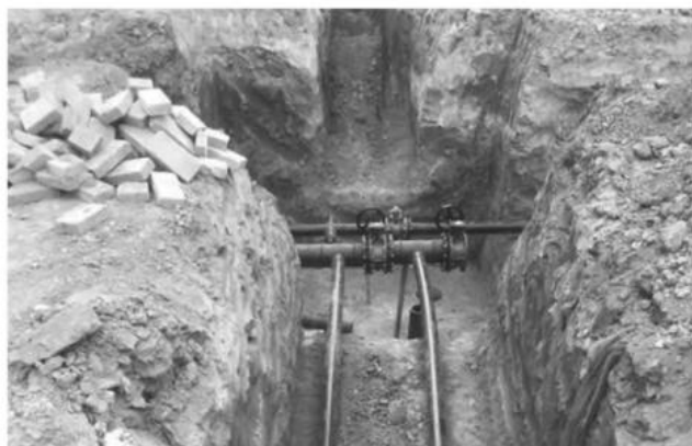
图 1 PE 管安装现场
