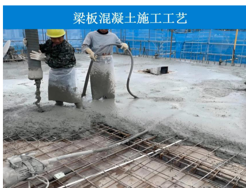
图1 梁板混凝土施工图
