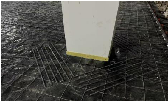
图3 柱边加强筋布置
