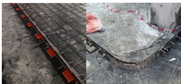
图2 铠甲缝安装
