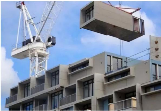
图 1 装配式建筑施工示意图
