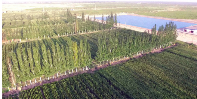
图 1 盐池县高效节水灌溉蓄水池
