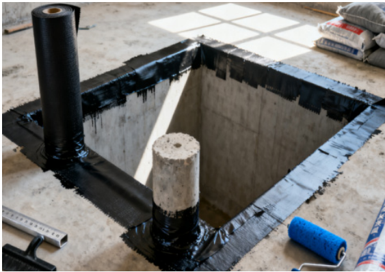
图2 集水坑施工
