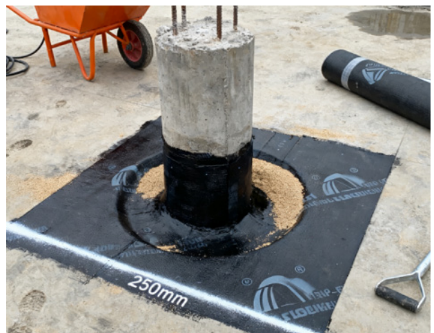
图 1 桩头施工
