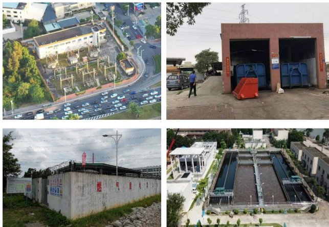
图1 110千伏西平变电站(左上)、东城42号垃圾转运站(右上)、常平司马调压站(左下)、石龙新区污水处理厂(右下)
