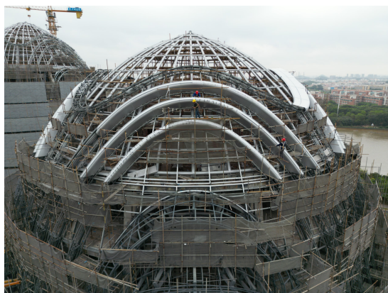
图 3 幕墙铝板现场安装
