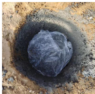
图 20 混凝土养护
