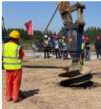
图 25 桩帽土模成型
