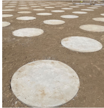
图 28 土模成型桩帽浇筑
