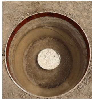
图 27 桩帽土模修边模板
