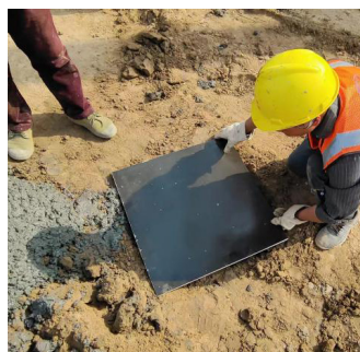
图 21 覆盖竹胶板防护
