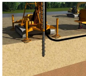
图10 钻机钻进
