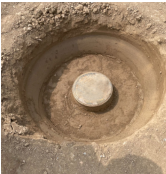
图 26 桩帽成型器开挖
