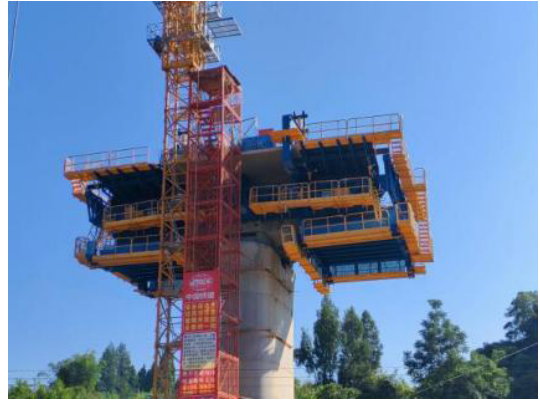
图 3 造桥机现场拼装成型图
