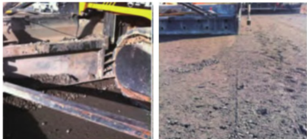
图 1 抗裂嵌挤型水泥稳定碎石基层摊铺
