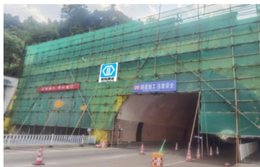
图2 现场施工概况图
