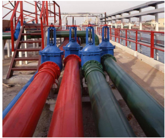
图1 外部涂层修复技术
