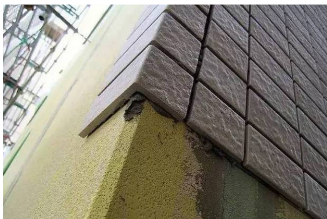
图1 建筑外墙保温施工
