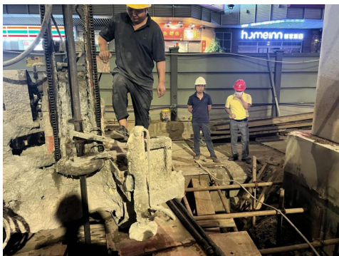
图 4 现场施工图片
