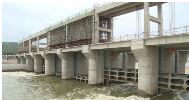
图1 水利水电工程设施
