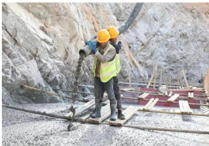
图2 水利工程混凝土浇筑
