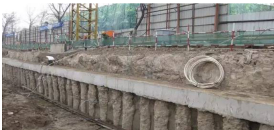
图1 水利工程深基坑支护施工现场
