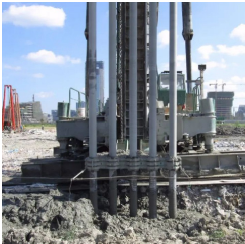
图 1 深层搅拌施工
