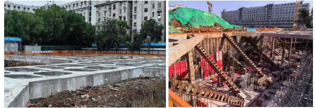
(a) 混凝土支撑施工
