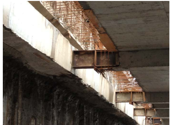
图七 负二层梁处的止水钢板焊接照片
