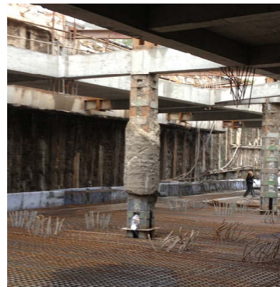
图六 负二层顶板结构梁与钢格构柱浇筑成形照片
