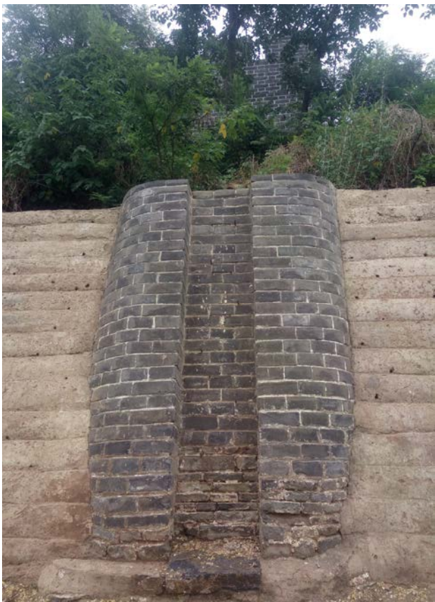
东墙修缮后的城壁水道
